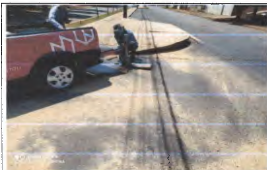
Serviço: Furo Sondagem
