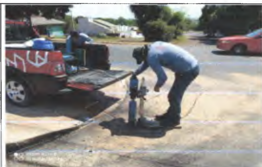
Serviço: Furo Sondagem
