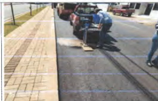
Serviço: Furo Sondagem
